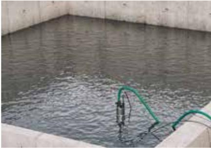
Clearox sind Tauchpumpen für die Entwässerung von klarem Wasser, ausgestattet mit einem Schwimmerschalter für den automatischen Betrieb und mit einem ergonomischen Griff für einen sicheren Halt und eine leichte Tragbarkeit. Dank des Kühlmantels kann die Pumpe sowohl untergetaucht als auch unter Wasser arbeiten.
